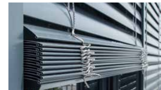
Kompaktes Lamellenpaket
